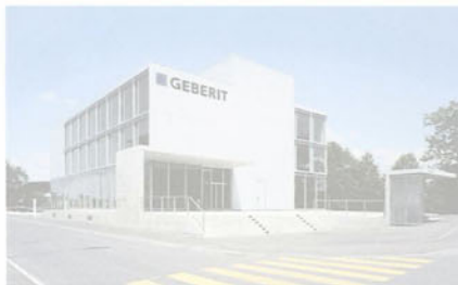
<16_ Elegante Industriearchitektur: Das Gerberit Informations- und Besucherzentrum empfängt bis 4000 Besucher pro Jahr. Foto: Markus Fischer
