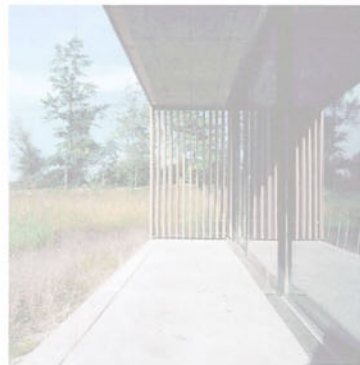
^15_ Der Kubus steht auf einer Pfahlfundation am Ende einer künstlichen Aufschüttung. Foto: Lorenz Bettler
