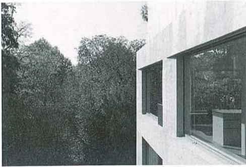
Tiefe, eingeschrägte Leibungen
