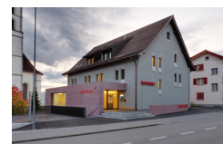
Der vorgesetzte Betonkubus bildet den neuen Eingang inkl. 24h Kundenzone und erweiterter Schalterhalle.
