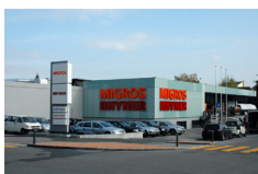
Die vorgehängte Glasfassade
