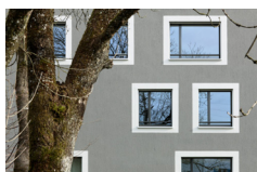
Fensteransicht an den Stirnfassaden
