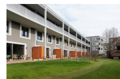
Südfassade mit privatem Aussenraum
