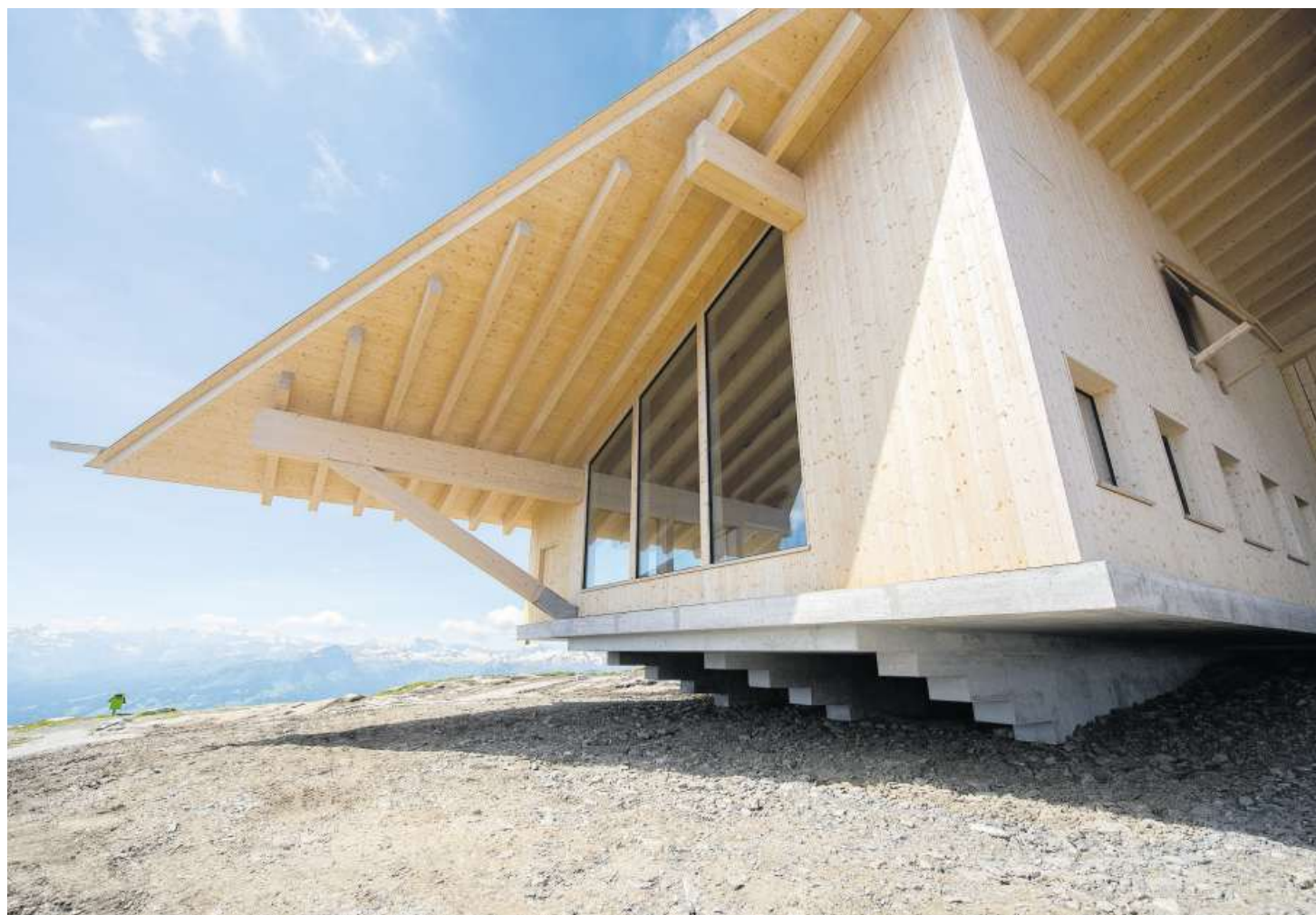
Die imposante, weit auskragende Dachkonstruktion der Bergstation Chäserrugg überzeugte die Jury des Prix Lignum.
