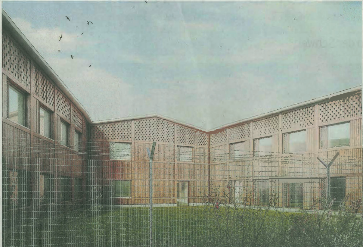
Modern und dem Verwendungszweck angemessen: das neue Vollzugszentrum Bachtel.
