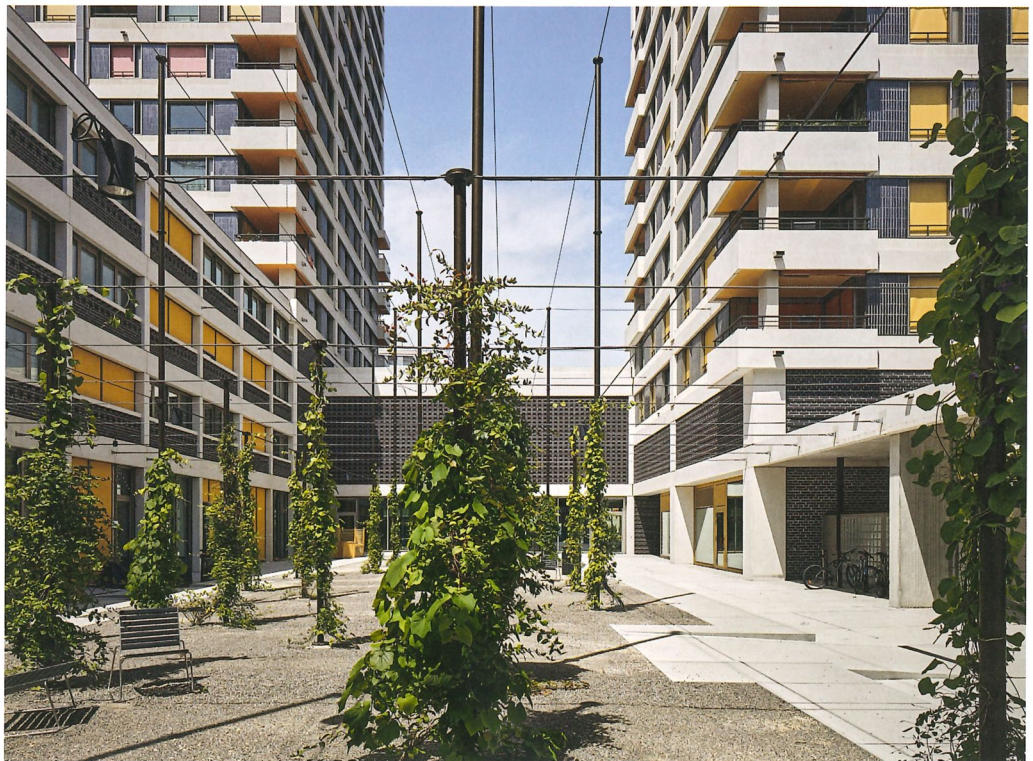
Am zentralen Hof präsentiert sich der nördliche Sockel als Wohnsiedlung – mit Patiowohnungen (rechts) und zweigeschossigem Atelierwohnen (links) am Fluss der Türme.
