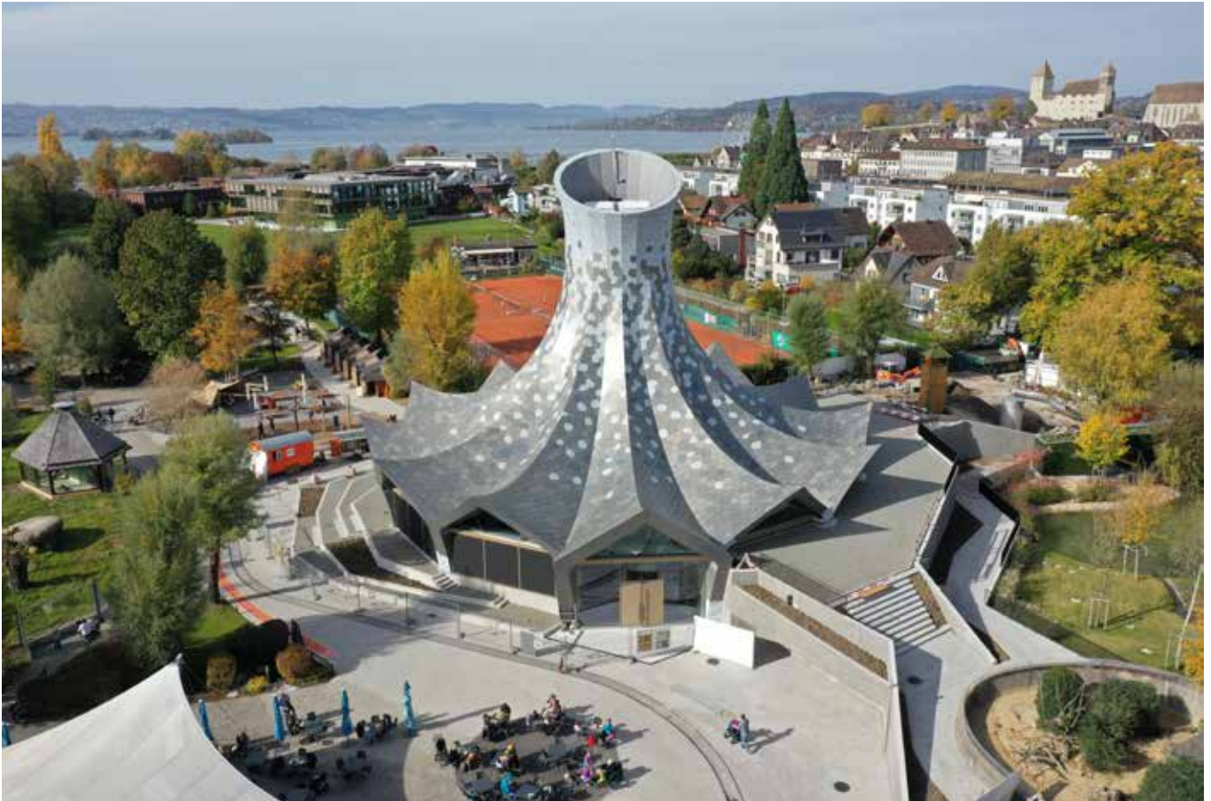
Bild 1: Die Dachform des fast 26 m hohen Gebäudes haben die Architekten von einem Tuch abgeleitet, das – wie von Zauberhand aufgehoben – das Darunterliegende offenbart. Das freitragende Zelt Dach ist als Schalenfaltwerk konzipiert. (Foto: Ghisleni Partner AG)
