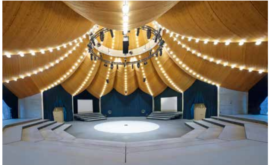
Bild 2: Ein Holztragwerk, das sich wie ein Baldachin zur Turmspitze schwingt. Das Schalenfaltwerk des freitragenden Zeltdachs verleiht dem Veranstaltungssaal im Inneren seine charakteristische Erscheinung. Der multifunktional nutzbare Bau verbindet die Zirkus-, Gesellschafts- und Erlebniswelten miteinander. Zur modernen Veranstaltungstechnik gehören unter anderem eine hydraulische Bühne sowie eine sechsstufige Manege-Tribüne, die bedarfsweise elektrisch ausgefahren werden kann. (Foto: Luca Zanier)
