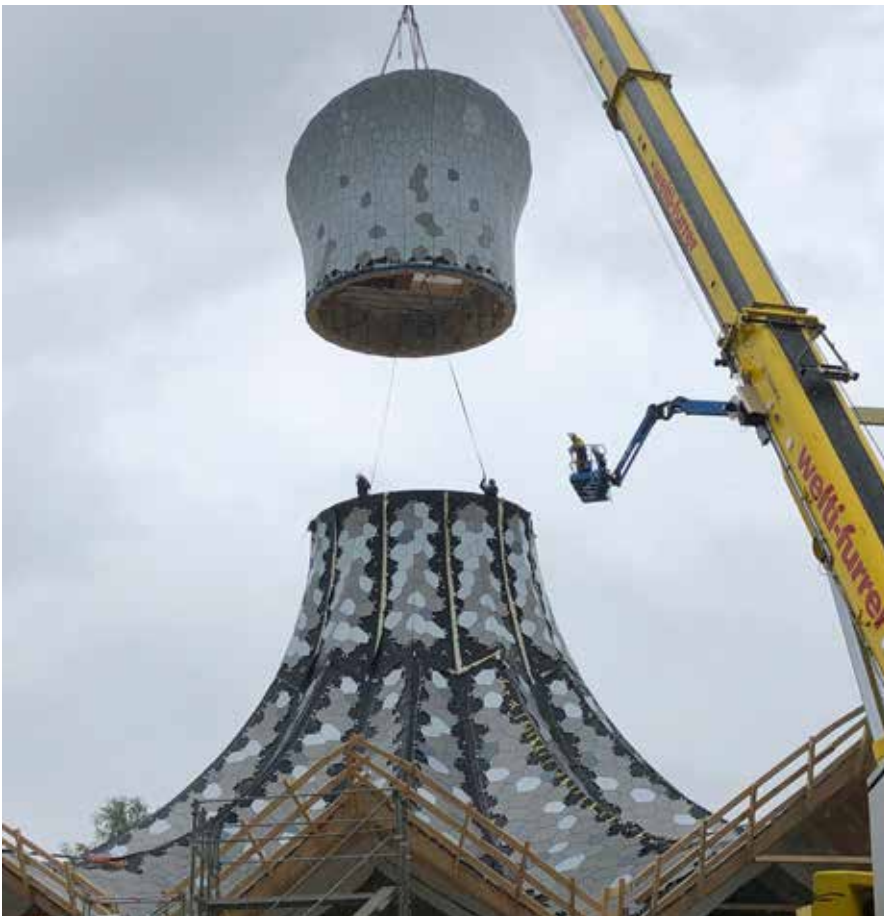
Bild 10: Aufsetzen der komplett vorgefertigten Haube bzw. Hutspitze. Das fast 20 Tonnen schwere Sonderbauteil mit einem Durchmesser von 7 m wurde mit einem Spezialkran eingehoben und passgenau montiert. (Foto: Beat Brännimann GmbH)
