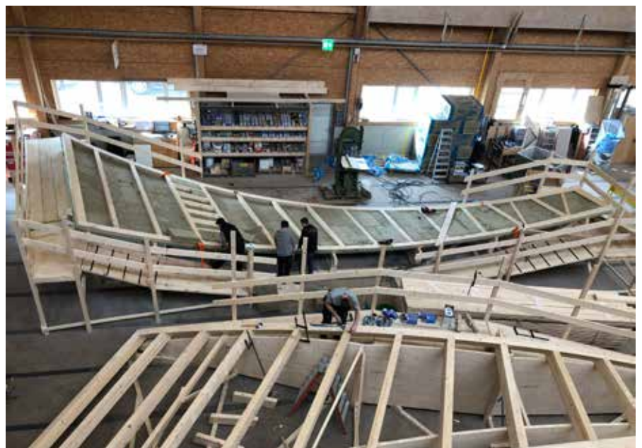
Bild 12: Vorne im Bild: Fertigung eines Dachelements auf einer Schablone. Hinten im Bild: Gewendetes Element mit ausgedämmten Gefachen. (Foto: PIRMIN JUNG Schweiz AG)
