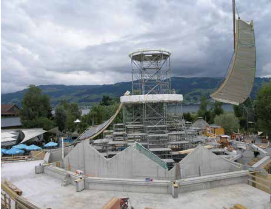
Bild 5: Der Stahlbeton-Unterbau ist fertig. Die ersten Dachelemente werden eingehoben. Sie spannen vom Stahlbeton-Zugring unten zum ersten BS-Holz-Druckring auf 11,50 m Höhe, den zunächst ein Montagegerüst stützt. (Foto: Blumer-Lehmann AG)
