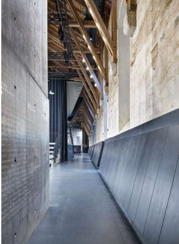
Die Holzverblendung der Aussenwände ist perforiert und hinterdämmt, um akustisch wirksam zu sein. Die ehemalige Reitspur geleitet zum mobilen Empfang, zur Backstage oder zu den Sitzplätzen.
