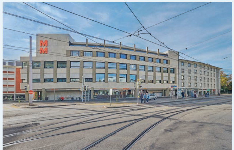
Beim Migros am Kreuzplatz in Zürich wurde mit eingefärbtem Ortsichtbeton und Natursteinelementen gearbeitet.
