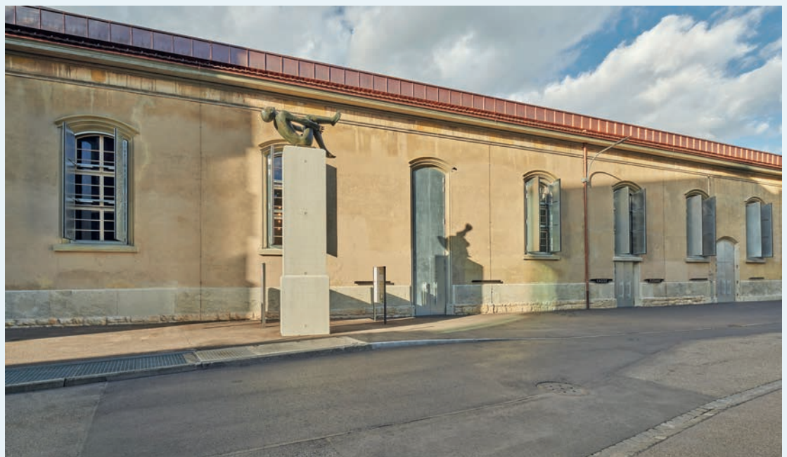
Steinmetzarbeiten und Natursteinelemente an der sanierten Fassade der alten Reithalle in Aarau.
